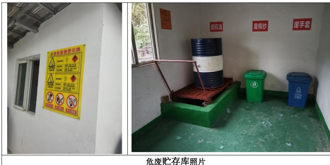
存在问题：电站危废贮存库地面防渗层厚度达不到要求，且墙面裙脚高度及防渗层厚度不满足相关要求，标识牌不规范，无双锁、分区不规范，危废贮存库建设不符合相应规范要求，未采取台账、转运联单等制度。
